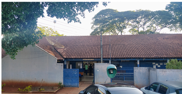
Foto 1 Fachada sem identificação
