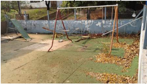
Foto 13: Parquinho necessita reparos.
