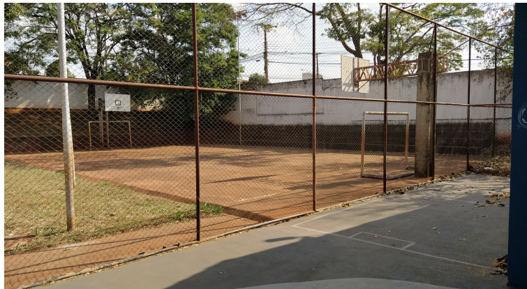
Foto 12 Quadra sem cobertura
