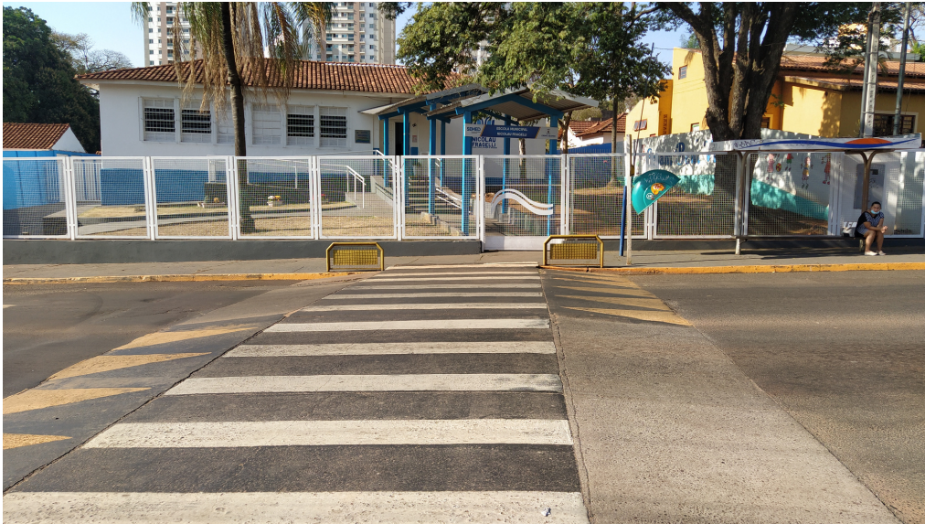
Foto 1 - Fachada em ótimo estado de conservação
