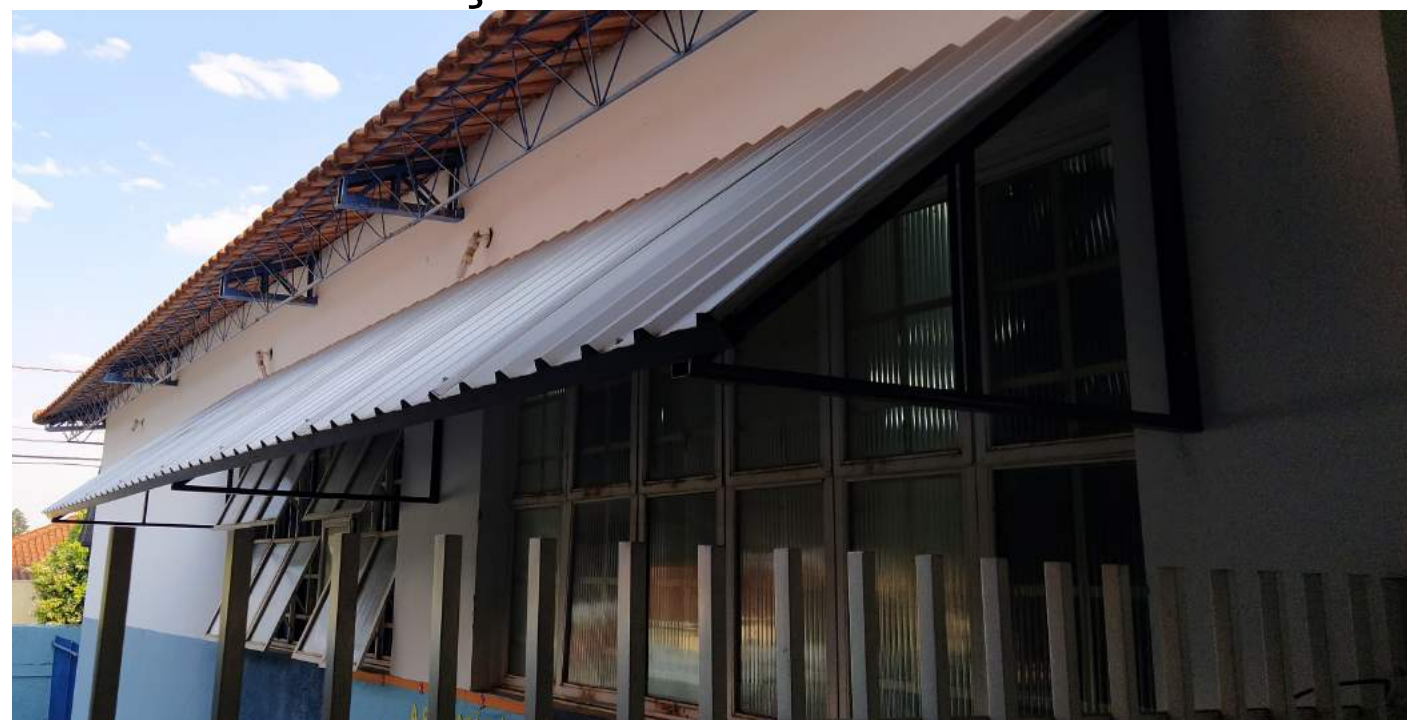
Foto 8: Coberturas novas nas janelas.
