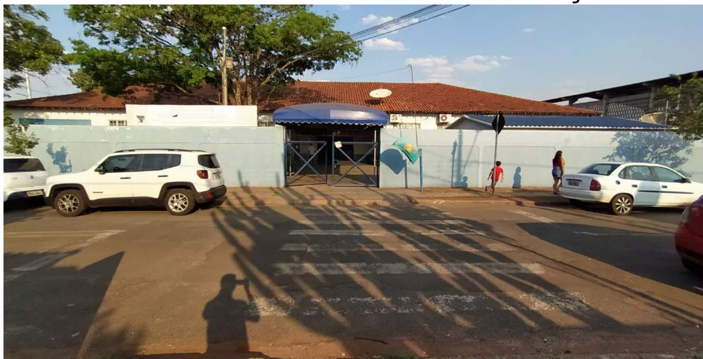
Foto 19: Faixa de pedestre desgastada.
