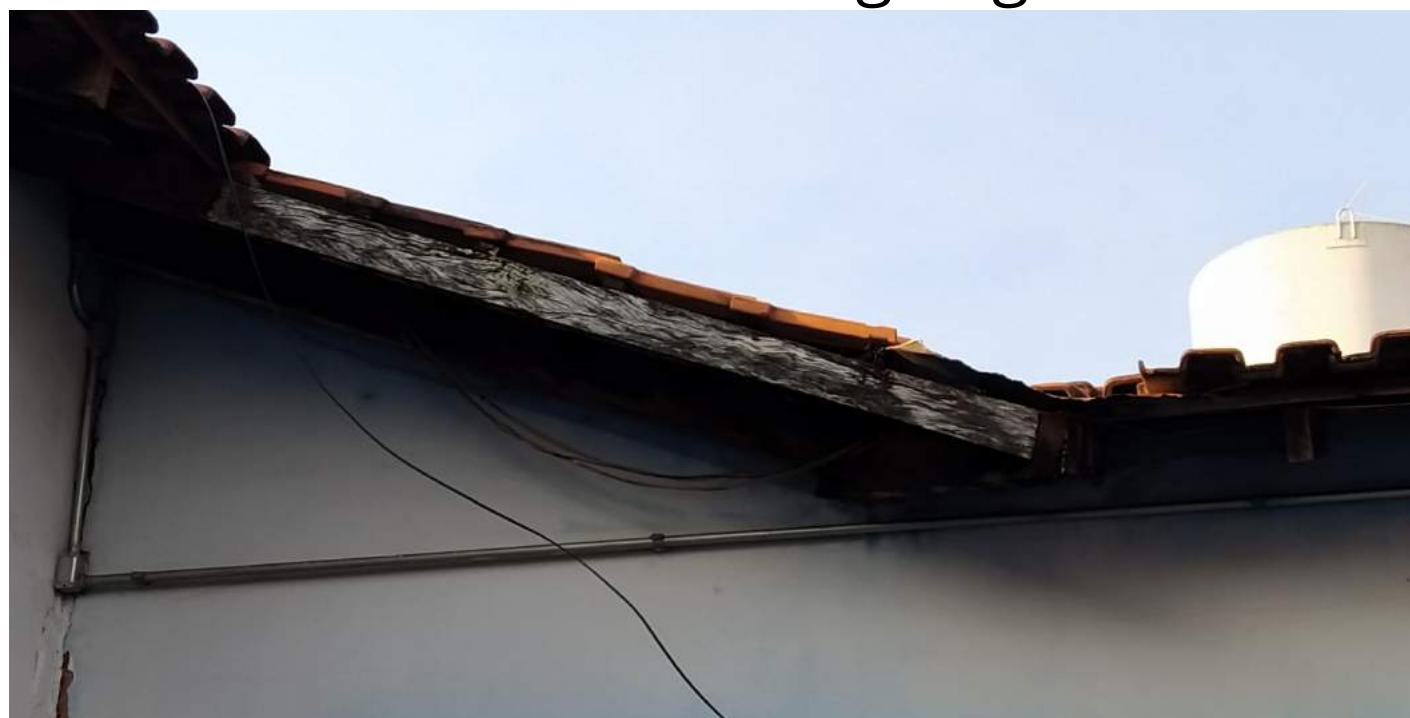
Foto 16: Madeiramento deteriorado.
