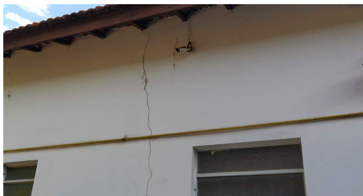
Foto 4: Rachadura externa.
