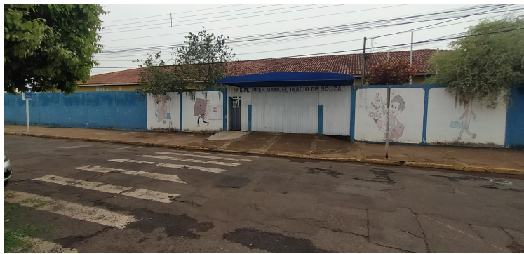
Foto 1 Ausência de faixa elevada
