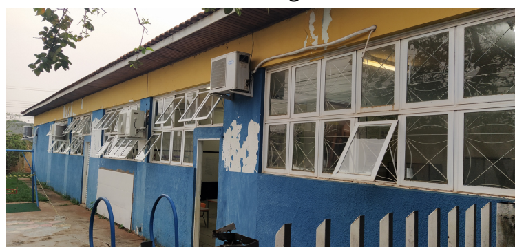
Foto 20 Ar-condicionado em todas as salas de aula
