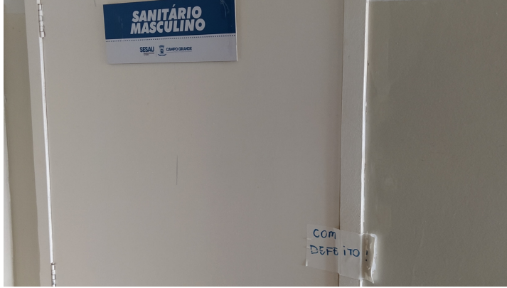
Foto 11: Banheiro novo e já interditado.
