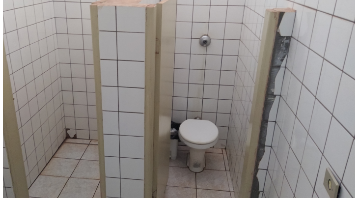
Foto 12: Banheiro dos servidores.
