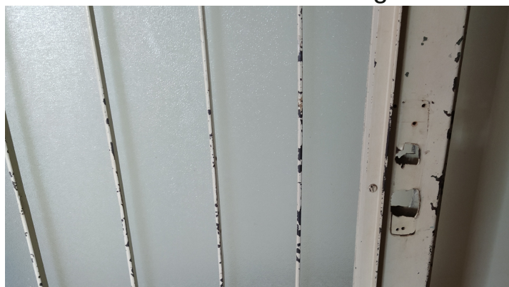
Foto 17: Porta de acesso ao corredor.
