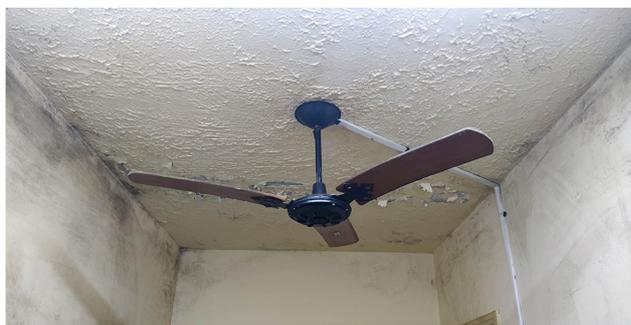
Foto 7 Teto com infiltração
