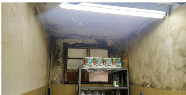
Foto 4 Paredes com infiltração
