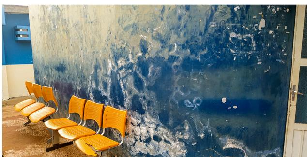
Foto 5 Parede com infiltração
