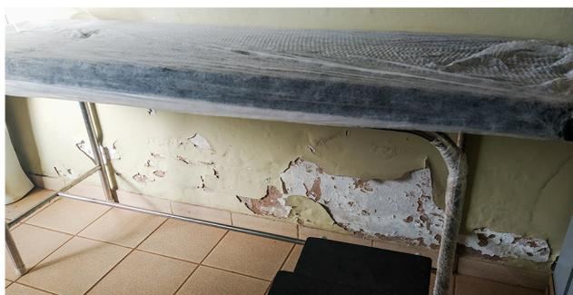
Foto 9 Parede com infiltração
