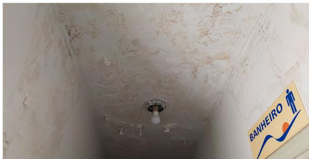
Foto 6 Paredes com infiltração
