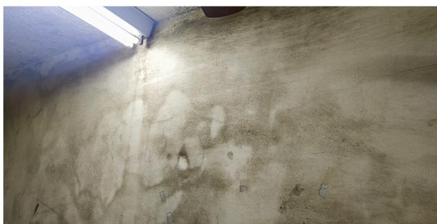
Foto 3 Parede com infiltração
