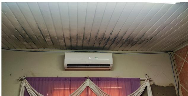
Foto 2 Teto com infiltração
