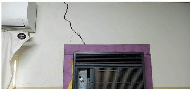
Foto 11 Estrutura com rachadura na odontologia
