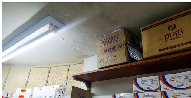
Foto 17 Teto com infiltração na farmácia
