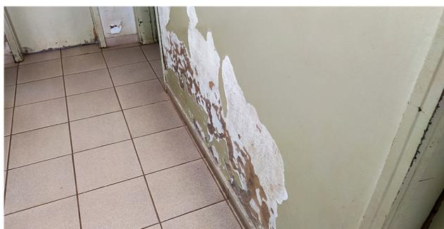
Foto 8 Paredes com infiltração
