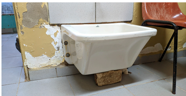
Foto 15 Lavatório quebrado
