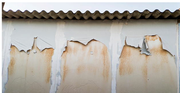
Foto 17 Parede Infiltração
