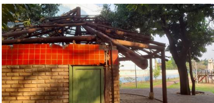
Foto 29 Telhado desfeito
