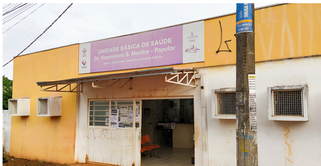
Foto 1 Fachada mal conservada
