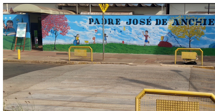
FOTO 4 FACHADA RECÉM PINTADA
