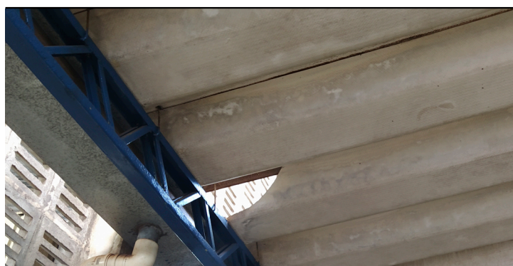
FOTO 2 TELHAS QUEBRADAS
