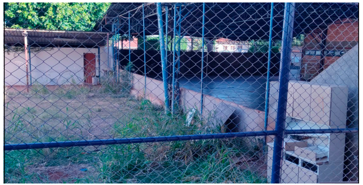
FOTO 2 ENTULHO NA QUADRA ANTIGA
