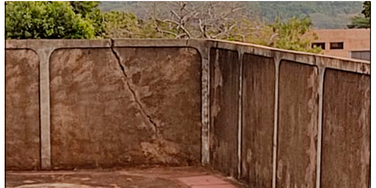
FOTO 14 MUROS QUEBRADOS
