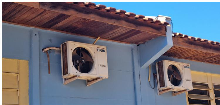
Foto 12 Ar-condicionado sem manutenção
