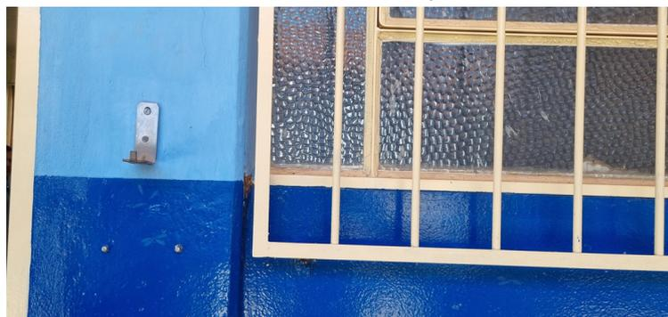
Foto 18 Ausência de extintor de incêndio
