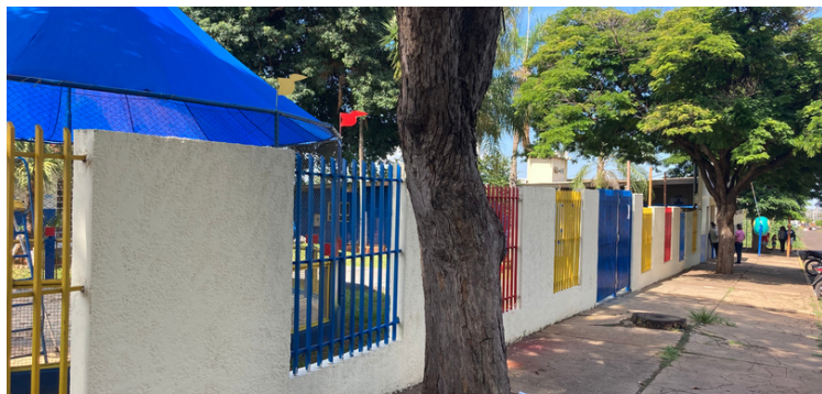
Foto 2 Fachada da escola
