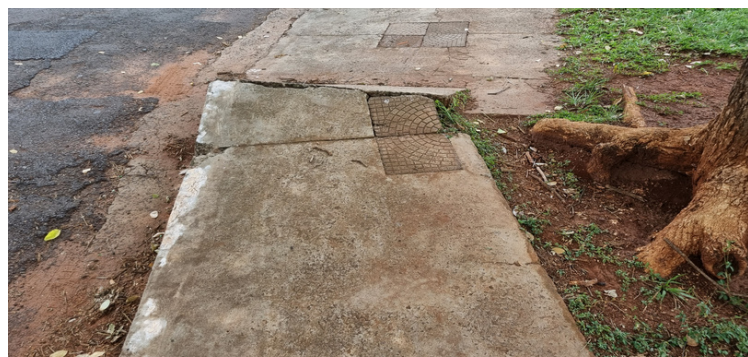
Foto 6 Calçamento levantado
