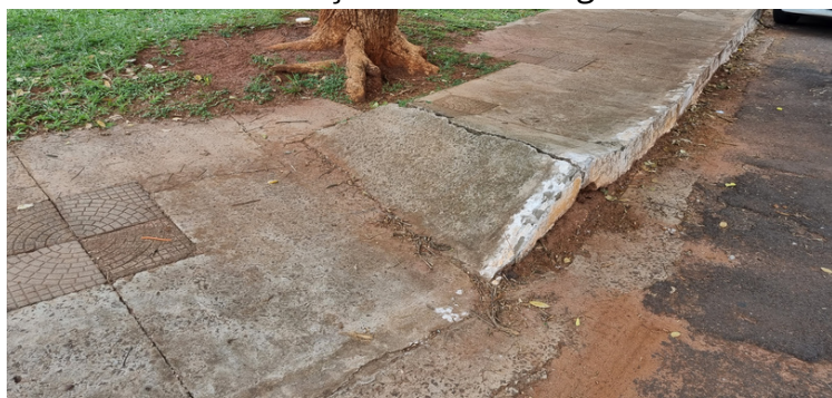
Foto 5 Calçamento levantado
