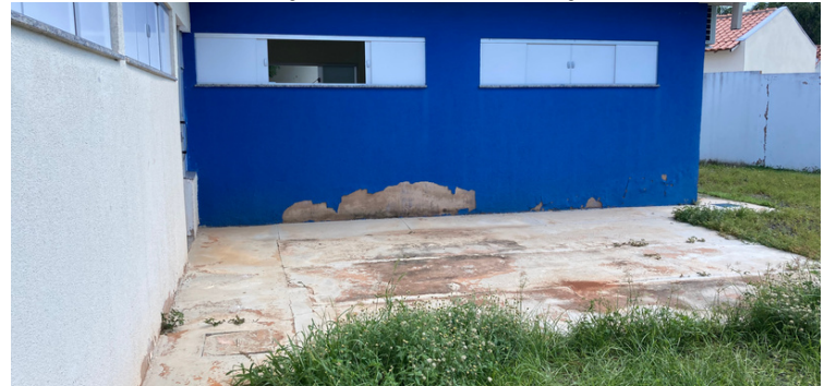
Foto 4 Infiltração externa
