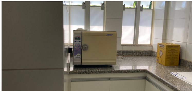
Foto 7 Autoclave com defeito
