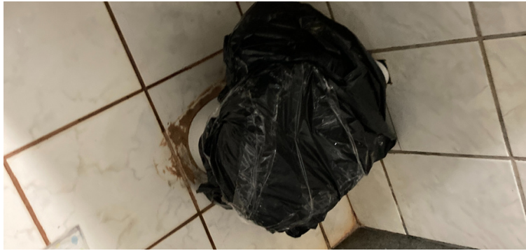
Foto 4 - Banheiros interditados por causa de entupimento.
