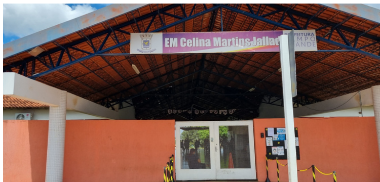
Foto 1 - Fachada da EM Celina Martins Jallad
