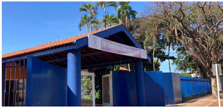
Foto 1 Fachada da Escola Municipal Domingo Gonçalves Gomes.
