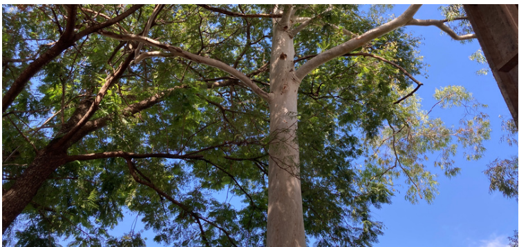
Foto 7 Árvore próxima a quadra de esportes com necessidade de remoção por estar causando danos a estrutura.
