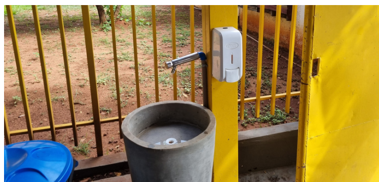
Foto 6 - Lavabo instalado na portaria
