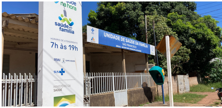
Foto 1 - Fachada da Unidade de Saúde São Francisco
