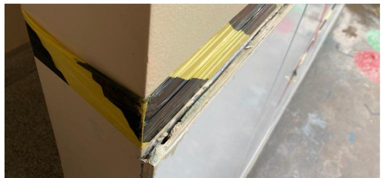
Foto 8 Acesso interdito, pois o revestimento da parede de azulejo está solto com risco de queda.
