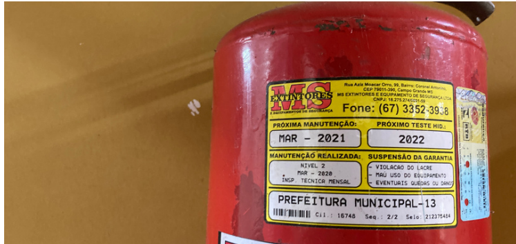
Foto 3 -Extintores com a data de validade expirada
