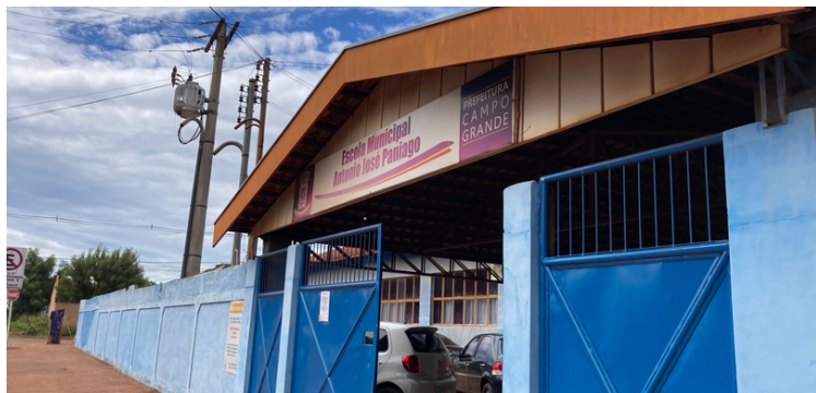
Foto 1 Fachada da escola
