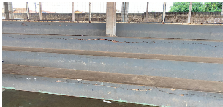
Foto 17 Rachadura na arquibancada da quadra de esportes.
