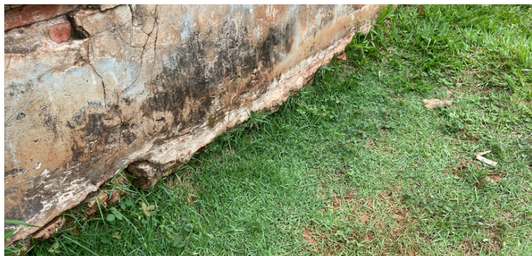
Foto 21 Infiltração
