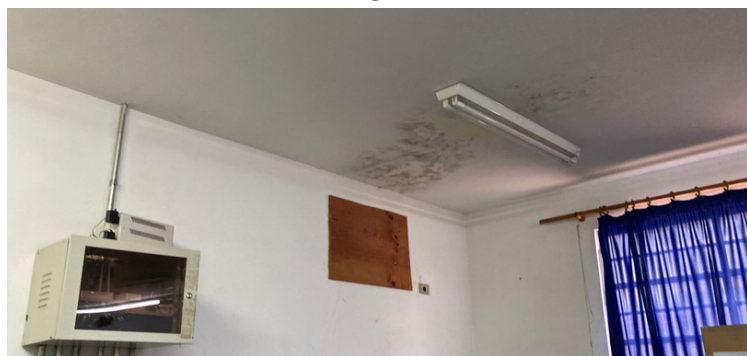
Foto 18 Infiltração
