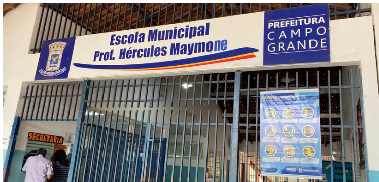
Foto 1 Fachada da escola
