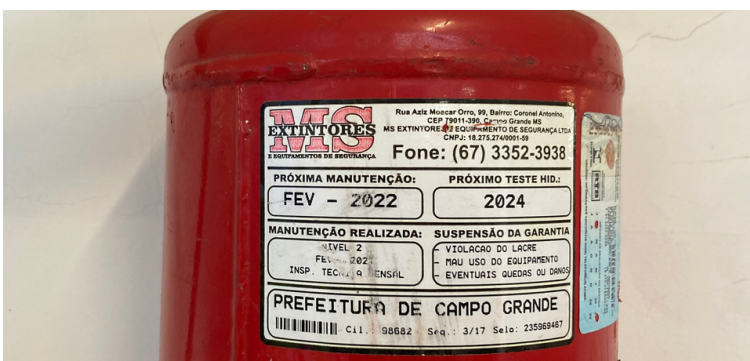
Foto 5 Extintor de incêndio com prazo de validade vencido.
