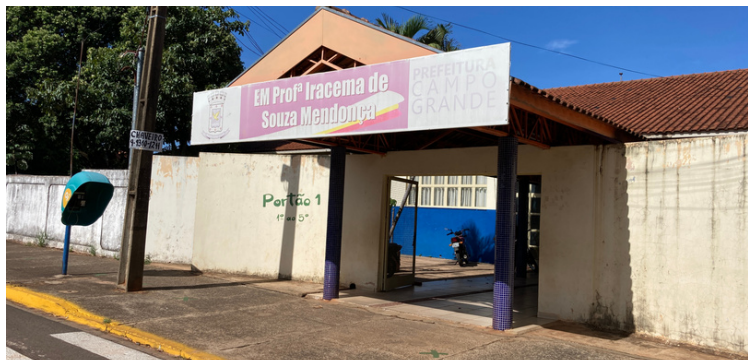
Foto 1 Fachada da escola
