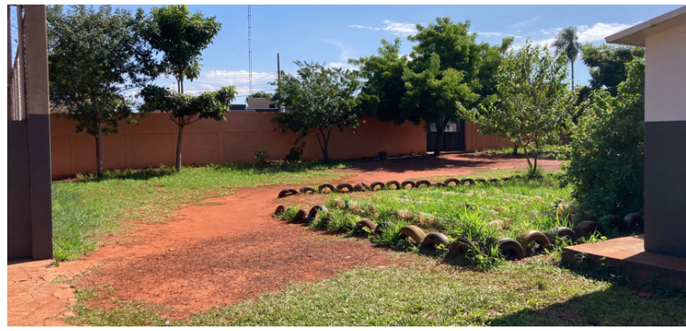
Foto 10 Falta de calçamento que interliga o portão de acesso até as salas de aula, dificultando a limpeza das salas de aula.
