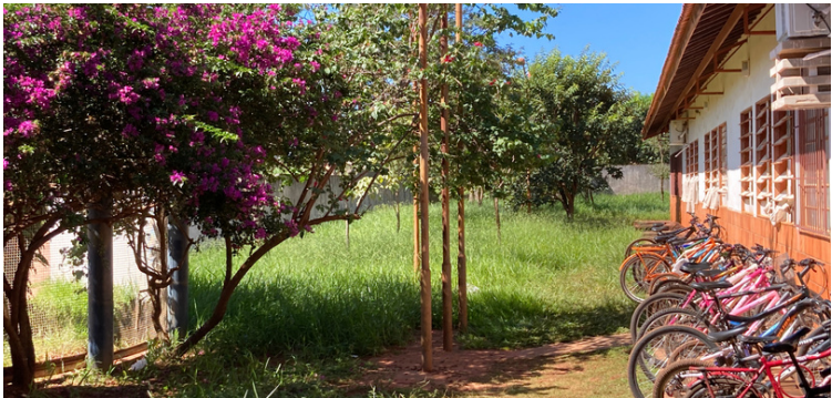
Foto 5 Área verde próximo a entrada da escola sem manutenção.
