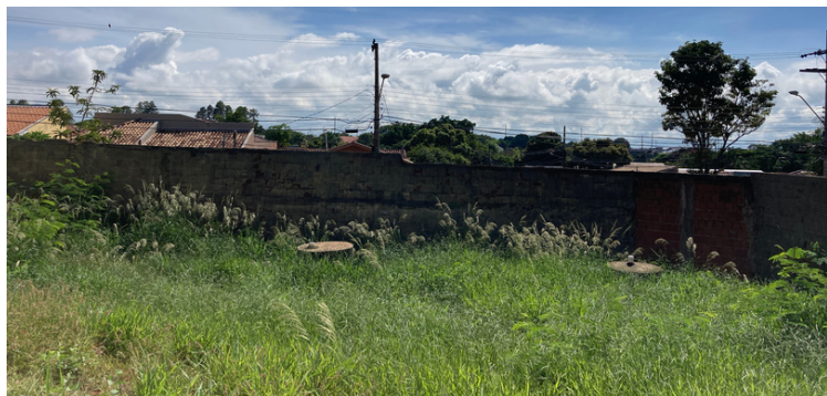
Foto 11 Área verde necessita de manutenção no fundo da escola
