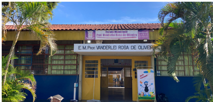
Foto 1 Fachada da escola
