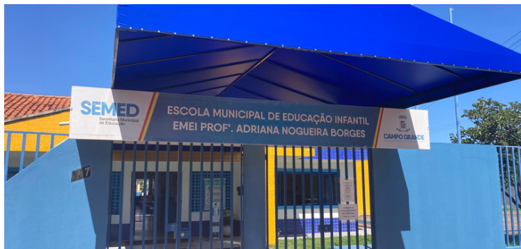
Foto 1 Fachada da escola
