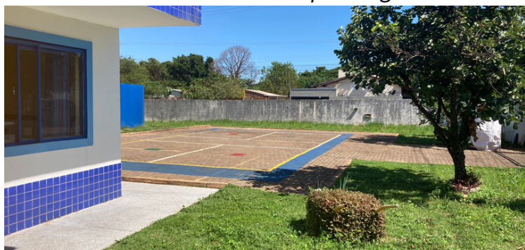
Foto Área externa da unidade com manutenção em dia
