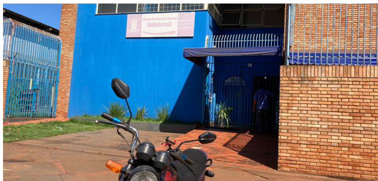
Foto 1 Fachada da EMEI Indubrasil.
