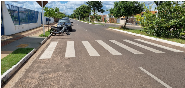
Foto 12 Necessidade de construção de faixa de pedestres elevada, pois há excesso de velocidade por parte dos motoristas.
