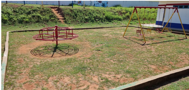
Foto 14 Necessidade de adicionar areia no parquinho.
