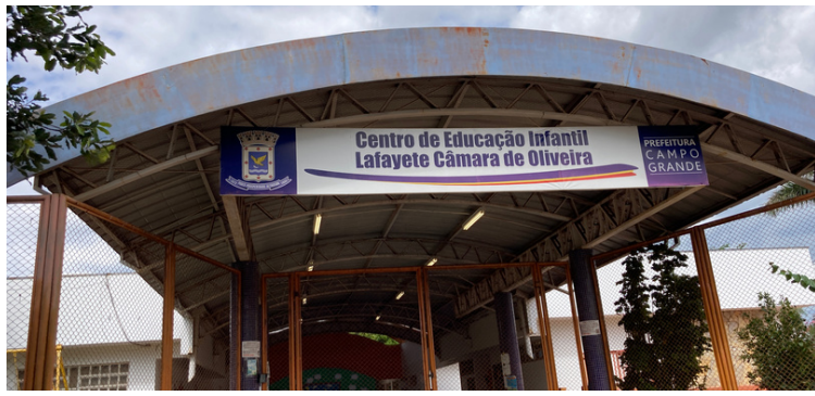
Foto 1 Fachada da EMEI Lafayete Câmara de Oliveira.
