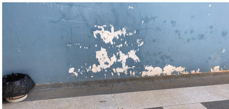
Foto 8 Pintura da parede descascada
