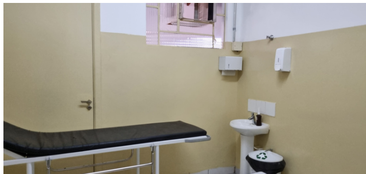
Foto 4 - Abertura na parede do consultório
