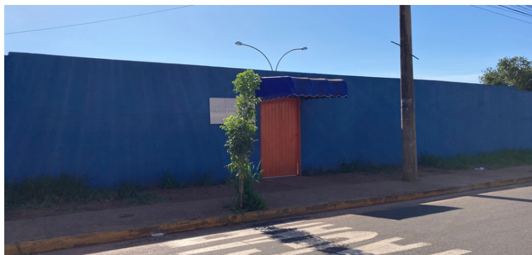
Foto 5 - Sinalização de trânsito necessária em um dos acessos da instituição
