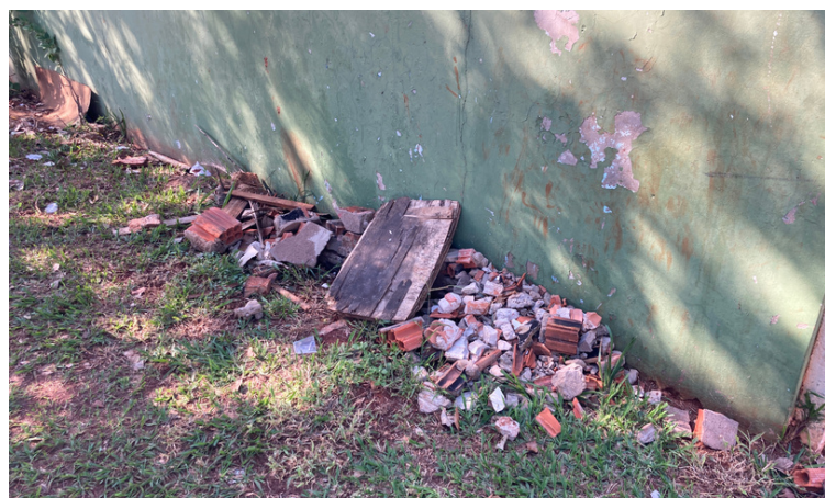
Foto 6 - Rejeito de tijolos indevidamente descartados
