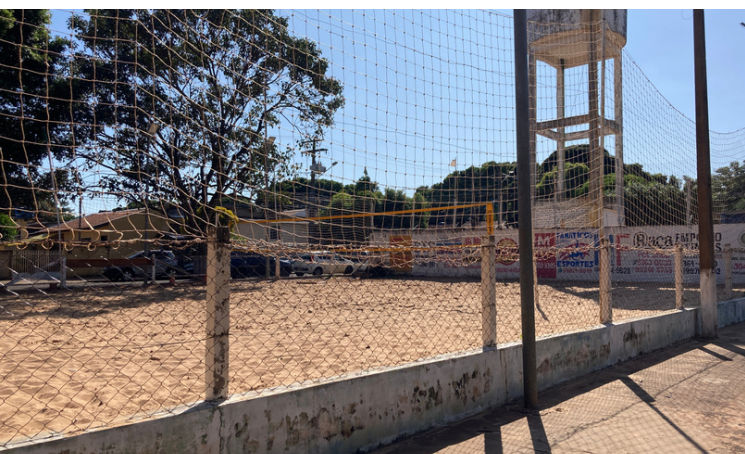
Foto 5 - Quadra para vôlei de areia necessitando de revitalização
