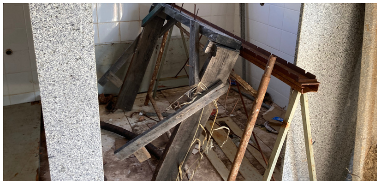
Foto 11 Obra do banheiro inacabada
