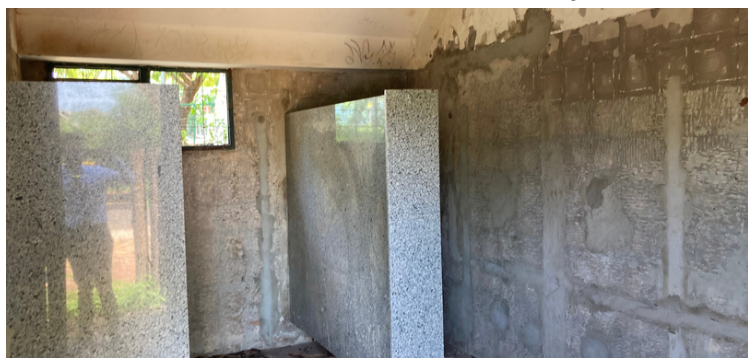
Foto 7 Obra do banheiro inacabada
