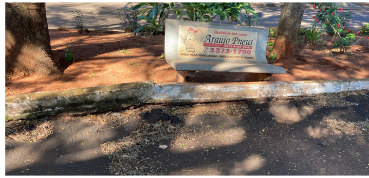
Foto 2 Banco desnivelado e com o assento solto.
