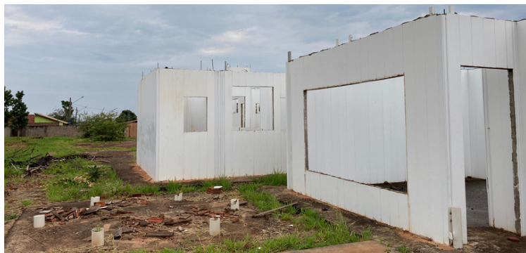
Foto 3 Estruturas da obra
