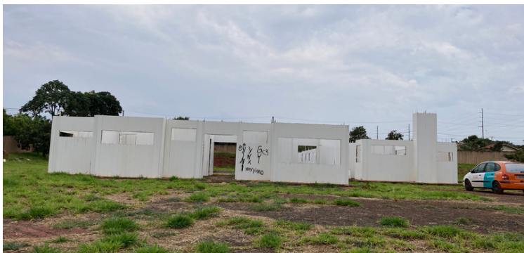
Foto 2 Frente da obra
