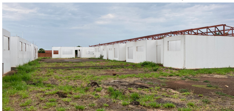
Foto 9 Fundos da obra
