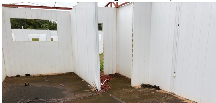
Foto 7 Parte interna da construção
