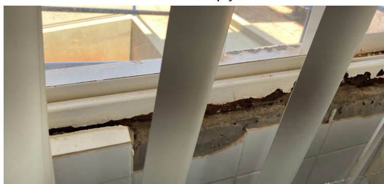
Foto 10 Ferrugem na janela
