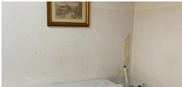
Foto 2 Pintura descascando
