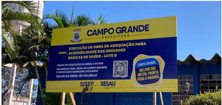
Foto 14 Placa de indicação da obra a ser realizada na unidade de saúde.
