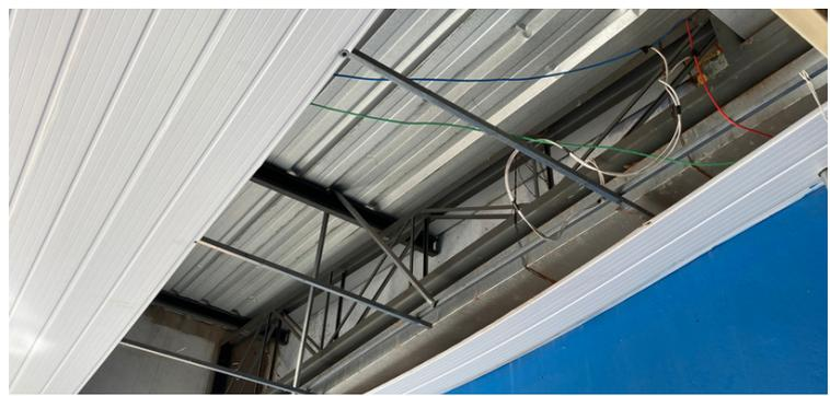
Foto 2 Forro danificado e fiação exposta
