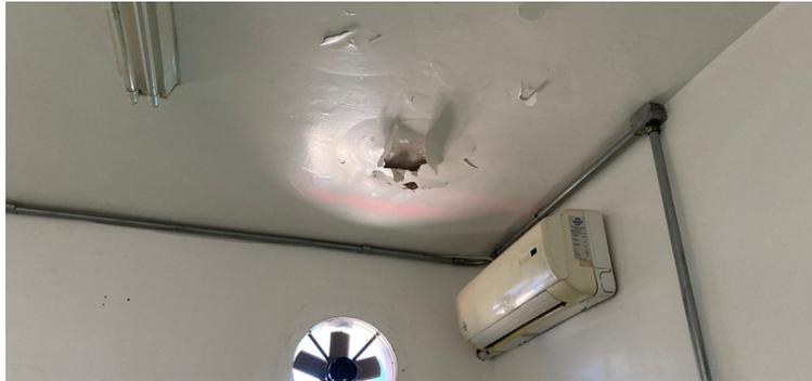
Foto 3 Infiltração na recepção
