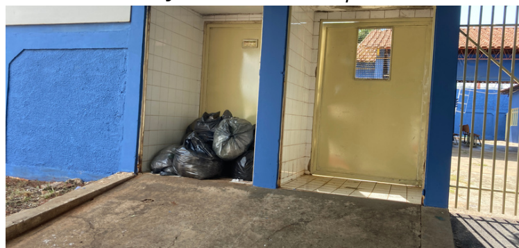
Foto 16 Lixeira sem proteção
