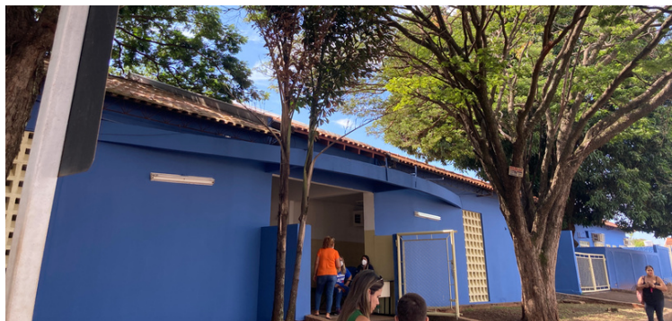
Foto 1 Fachada da unidade
