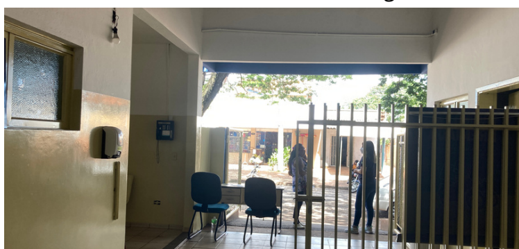
Foto 9 Saída sem placas de identificação
