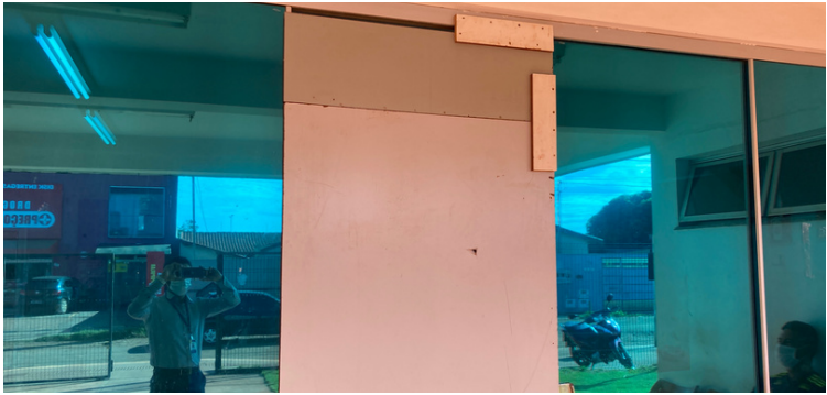
Foto 3 Tapume de proteção em local que o vidro foi danificado.
